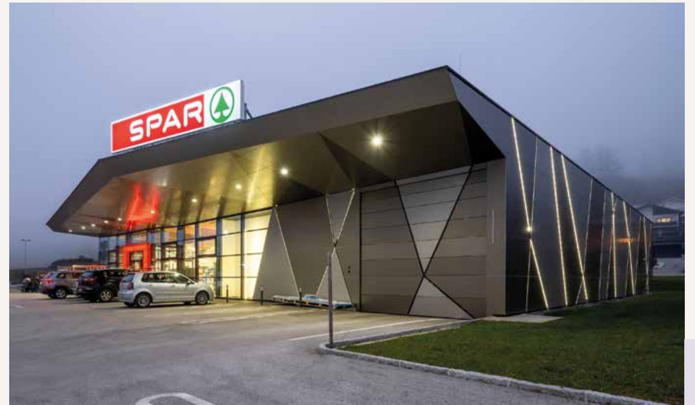
Bei Dunkelheit sind die Fugen der Fassadenplatten hinterleuchtet, dies verleiht dem Baukörper ein spannendes Erscheinungsbild.
