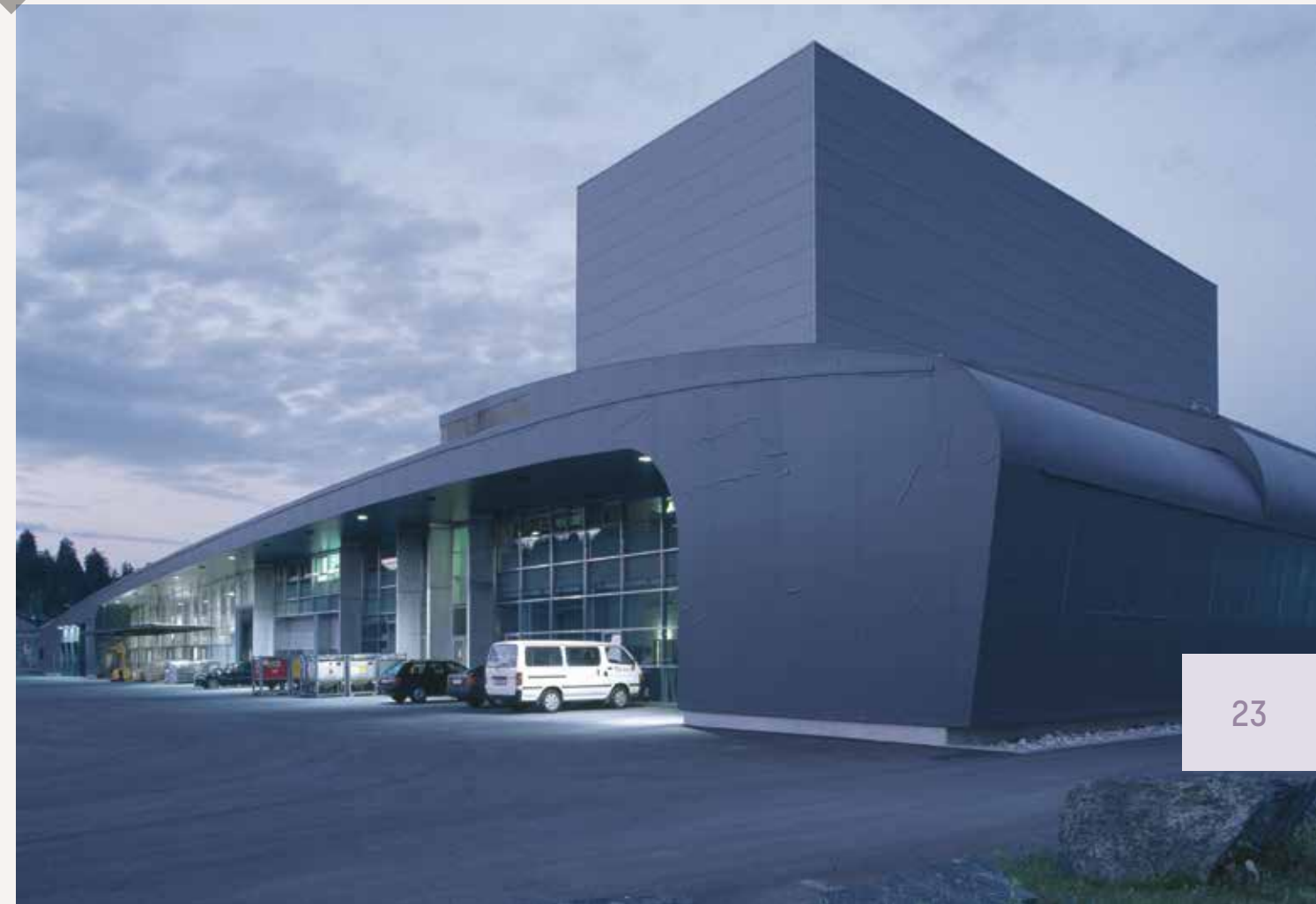
Das Gebäude mit dem Druckwerk-Turm von Westen gesehen.
