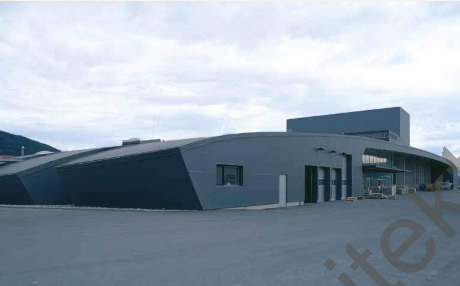
Die Dachhaut ist wie eine Hülle auch über die Fassaden gezogen.
