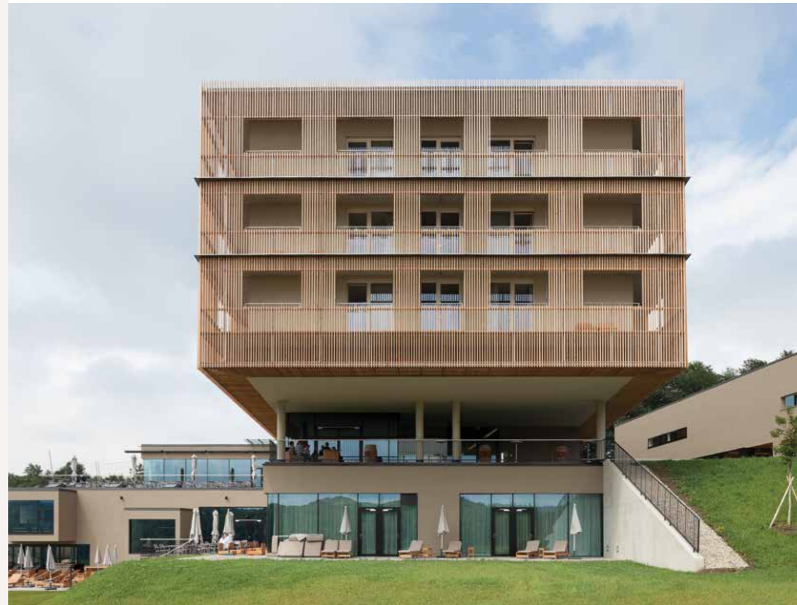
Südansicht des Hotels mit auskragendem Baukörper über dem Eingang und dem Spabereich im Untergeschoß.
