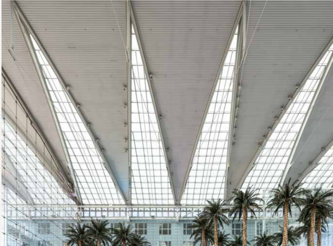
Die fünfzehn Meter hohe Hotellobby ist von einem Tonnendach überspannt.
