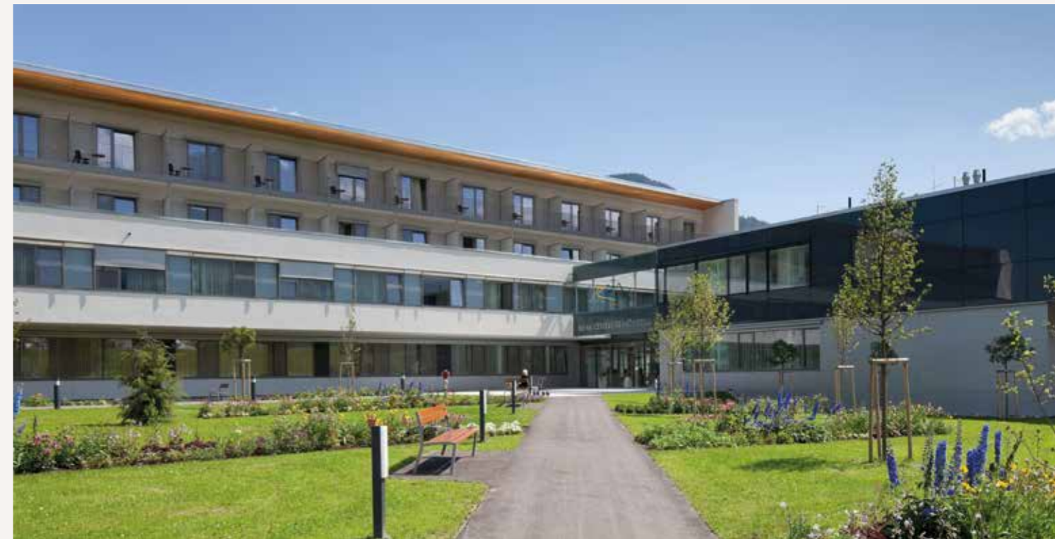
Der nordseitige Grünraum der Anlage im Eingangsbereich ist als Park angelegt.
