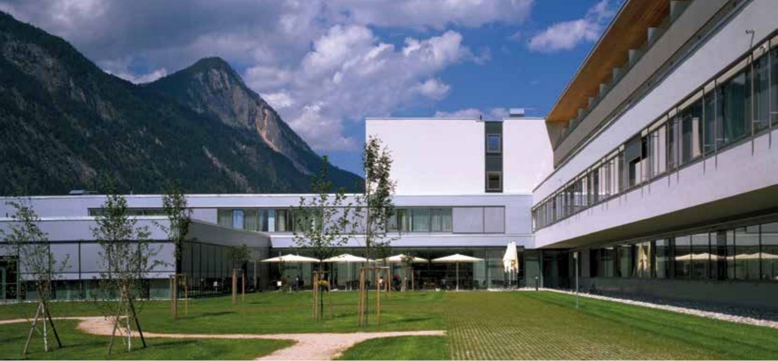
Blick von Südwesten auf den Außenbereich der Cafeteria, der in einem geschützten Semiatrium liegt.
