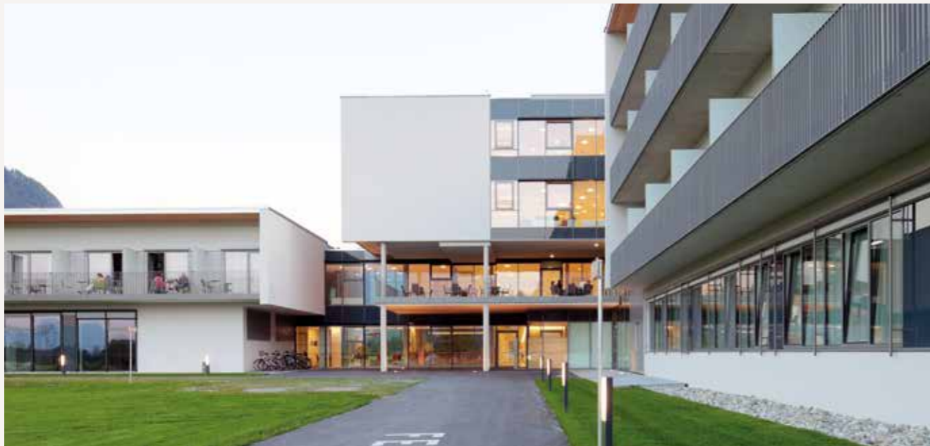
Der Eingangsbereich liegt im Zentrum des im Grundriss kreuzförmigen Gebäudekomplexes.
