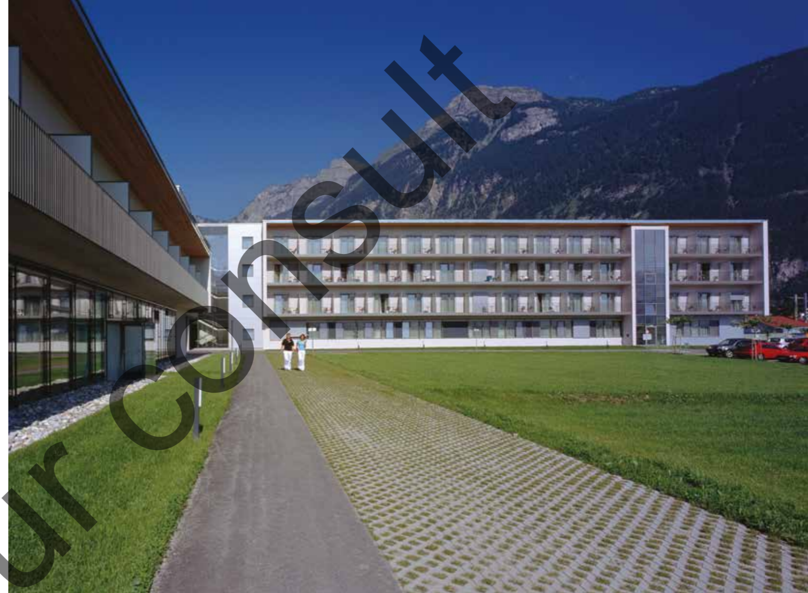
Die ostseitige Fassade eines Bettentrakts des Reha-Zentrums mit dem beeindruckenden Bergpanorama als Hintergrund.
